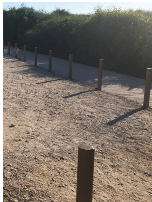
Kuva 11. Esimerkki puutolpista, joilla voidaan erottaa pyöräkaista pysäköintialueen reunaan. Kuva: Riikka Nousiainen.
